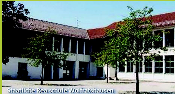
Staatliche Realschule Wolfratshausen
