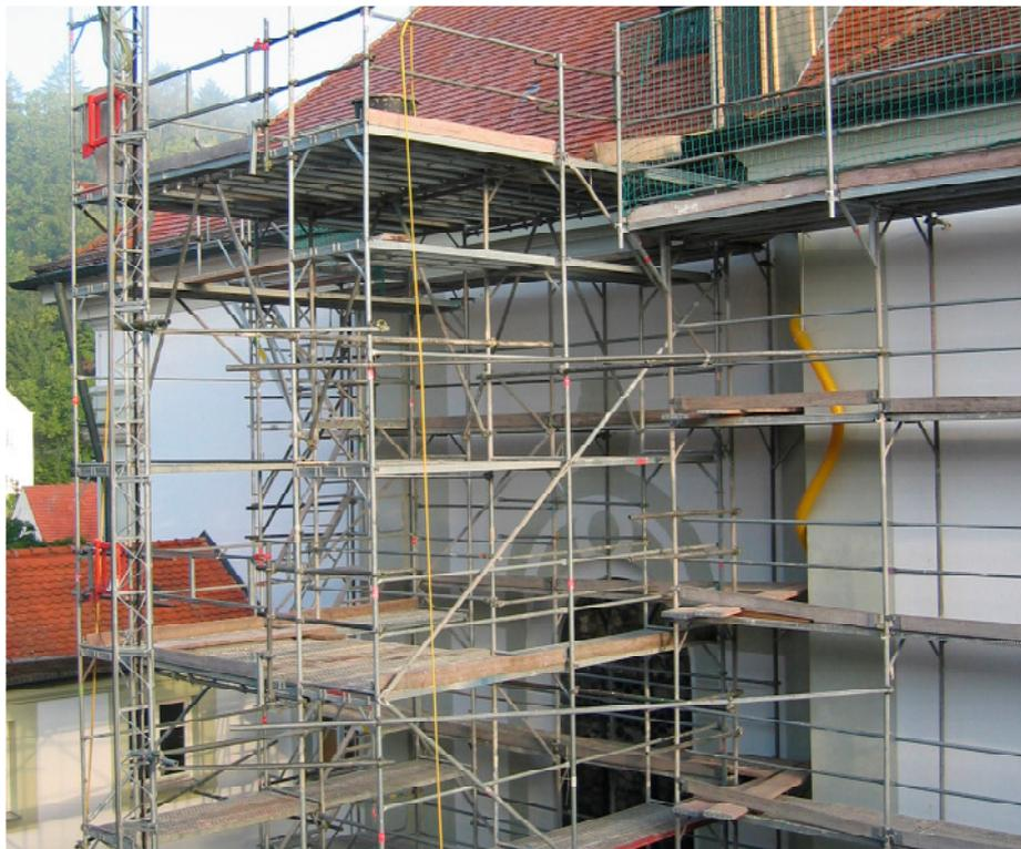
*Gerüst im südlichen Innenhof mit Lastenaufzug zur Baustelle unter dem Dach*
